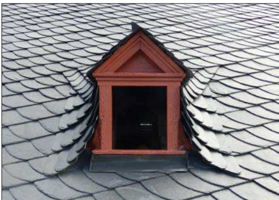
Abb. oben: Dachstuhl nach Räumung und Freistellung Abb. Mitte links: Gaube 2. Dachgeschossebene Rheinseite nach Instandsetzung Abb. unten links: Gaube 2. Dachgeschossebene Straßenseite nach Instandsetzung Abb. unten rechts: Gaube 1. Dachgeschossebene nach Instandsetzung
