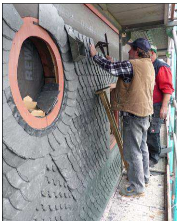
Abb. oben links: Schäden an der Fachwerkkonstruktion nach Abnahme der Verkleidung Abb. rechts: Westgiebel nach Instandsetzung Abb. unten links: Wiederherstellung der Schiefer-Ornamente Abb. unten Mitte: Wiederherstellung der Wasserschläge
