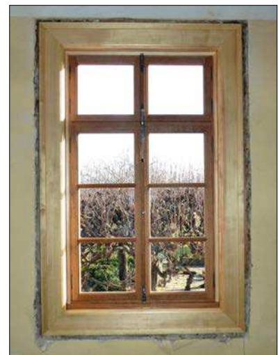
Abb. oben: Wieder hergestellte Fensteröffnung mit Rekonstruktion von Futter, Bekleidung und Fenster (Mitte) Abb. unten links, Mitte: Rekonstruktions-Fenster im Gastronomiebereich, Innenansicht Abb. unten rechts: Rekonstruktionsfenster im Obergeschoss, Innenansicht
