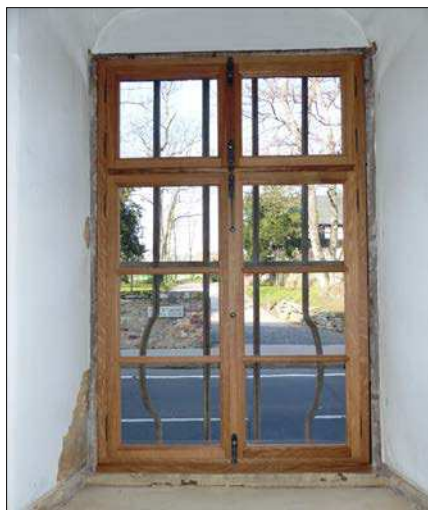
Abb. oben: Wieder hergestellte Fensteröffnung mit Rekonstruktion von Futter, Bekleidung und Fenster (Mitte) Abb. unten links, Mitte: Rekonstruktions-Fenster im Gastronomiebereich, Innenansicht Abb. unten rechts: Rekonstruktionsfenster im Obergeschoss, Innenansicht
